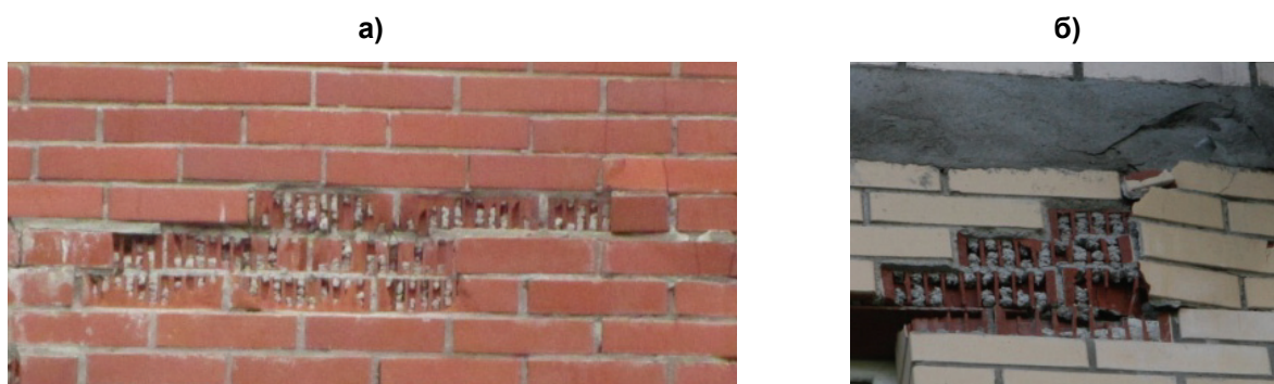
Рисунок 3. Заполнение щелей строительным раствором во время кладочных работ: а – выкрашивание кирпичей на торцевых участках плит перекрытий; б – выкрашивание кирпичей на участке примыкания к плите перекрытия
