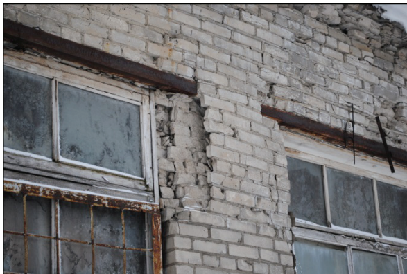
Рисунок 6. Выпучивание наружной версты кладки вследствие размораживания и потери прочности
