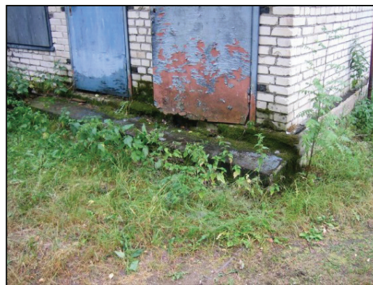
Рисунок 2. Биоповреждение цокольной зоны
