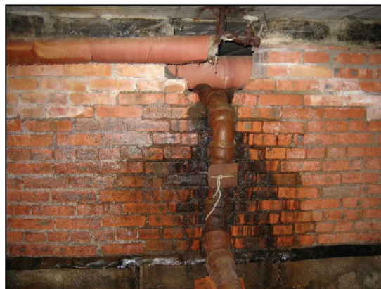
Рисунок 4. Увлажнение стены вследствие протечек системы канализации
