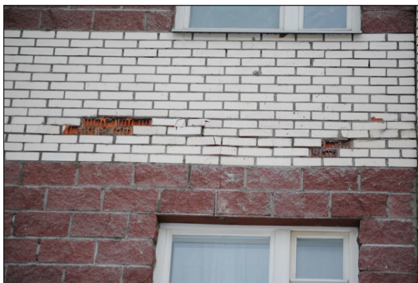
Рисунок 3. Разрушение облицовочного кирпича из-за конденсации влаги на стальных уголках внутри кладки
