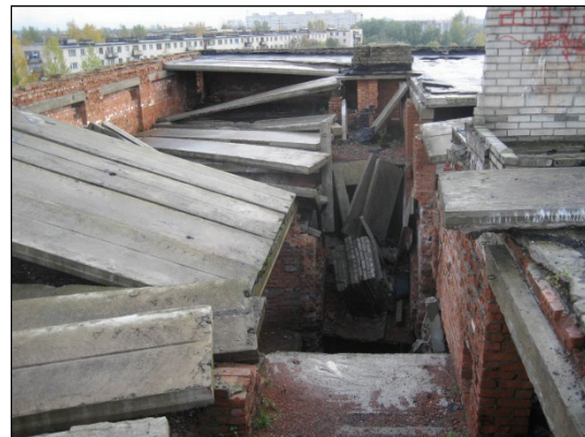
Рисунок 7. Обрушение плит покрытия из-за потери несущей способности размороженной кладки внутренних стен недостроенного здания
