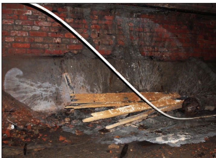
Рисунок 8. Домовой гриб на кирпичной кладке
