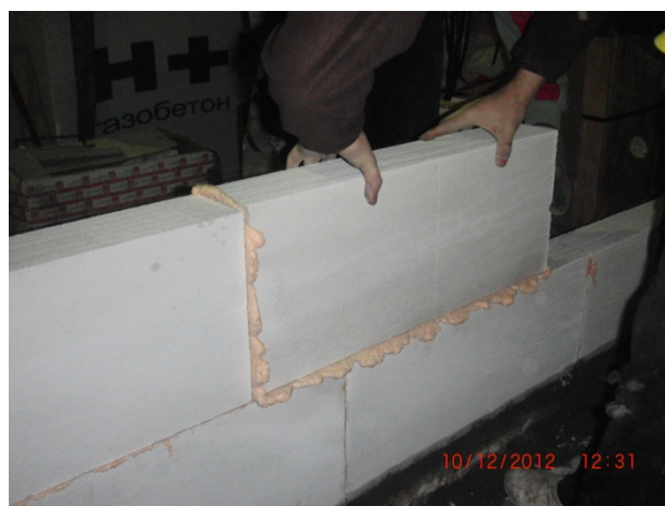
Рисунок 11. Укладка следующего ряда кладки испытываемого образца
