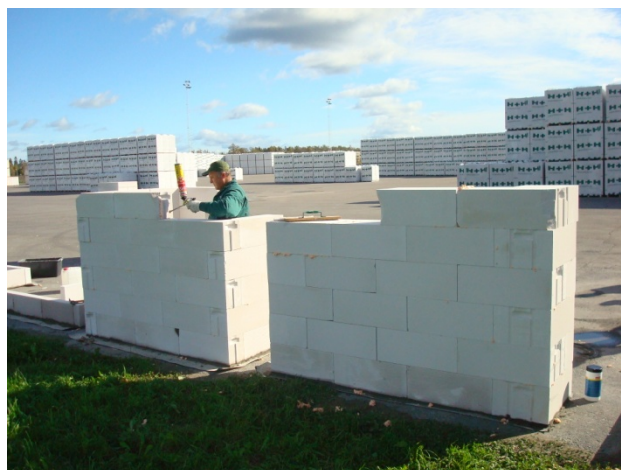
Рисунок 4. Процесс нанесения ППУ-клея на вертикальную (торцевую) поверхность блоков
