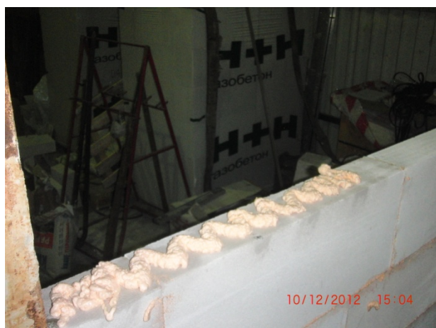
Рисунок 10. Нанесение ППУ-клея на поверхность очередного ряда кладки испытываемого образца
