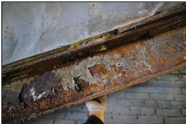
**Рисунок 10. Коррозионное повреждение элемента фермы**
