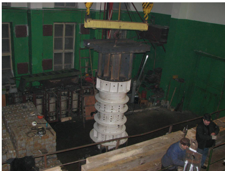
Рисунок 5. Монтаж опытного образца гидродемпфера
