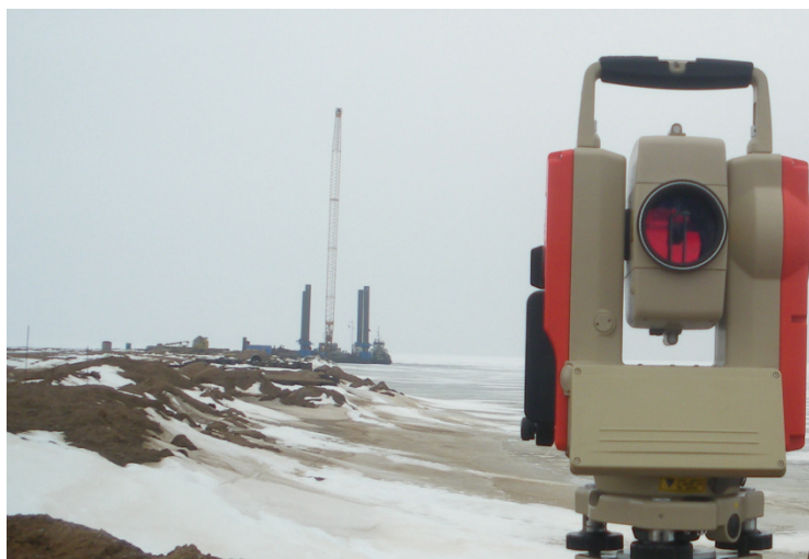
Рисунок 5. Электронный тахеометр Pentax R 325NX. Общий вид морского участка дамбы
