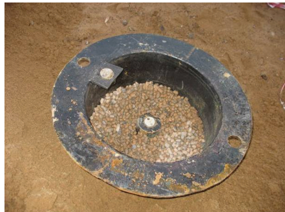
Рисунок 3. Первоначальный вид БИТ после установки
