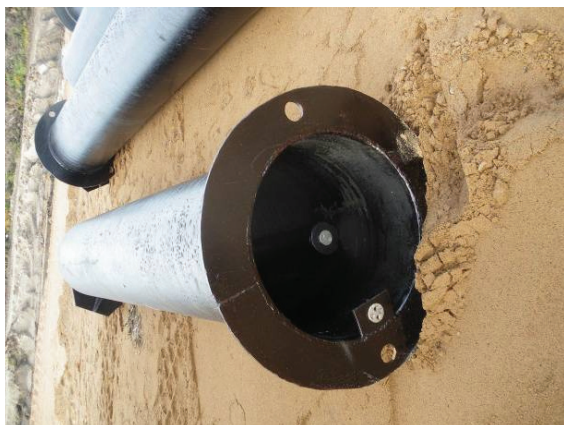
Рисунок 2. Глубинная и поверхностная марки до установки
