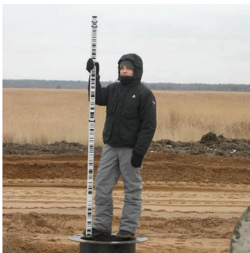
Рисунок 4. Снятие отсчета с помощью штрихкодовой рейки GSS 111. Вид на БИТ после установки
