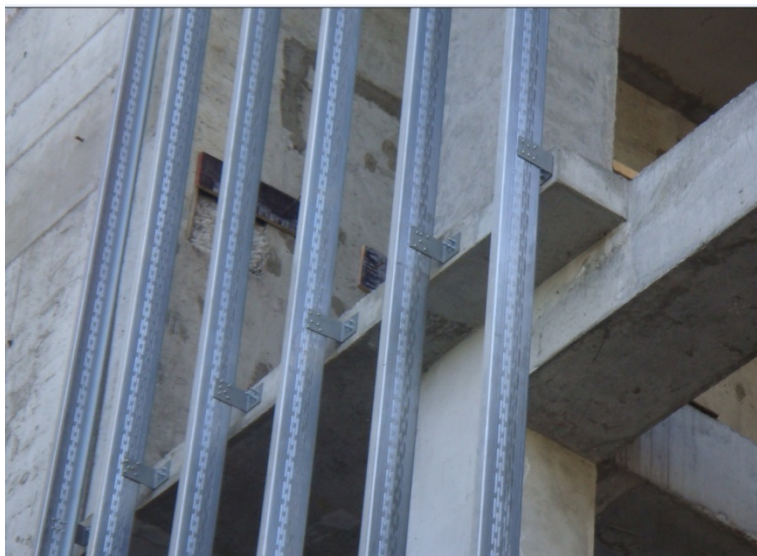
Рисунок 1. Вариант ограждающей конструкции: навесная конструкция стены
