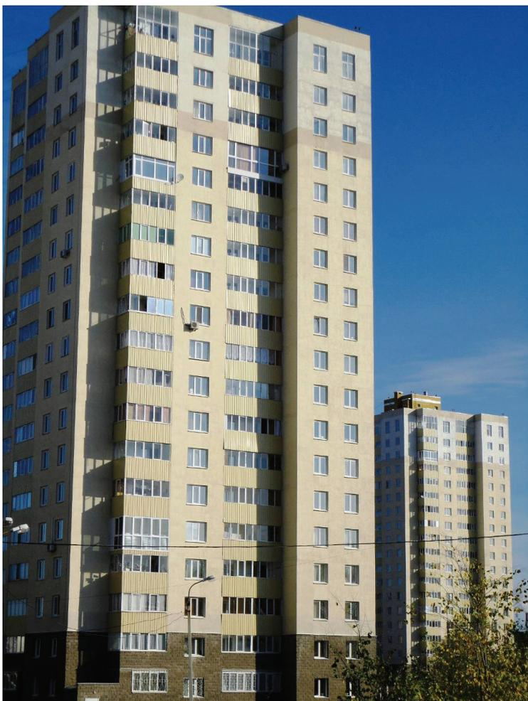
**Рисунок 1. Многоэтажные жилые дома в м-не Сипайлово г. Уфы с наружными стенами из автоклавных газобетонных блоков и фасадной отделкой в виде декоративно-защитного покрытия из материалов системы «Баумит»**
