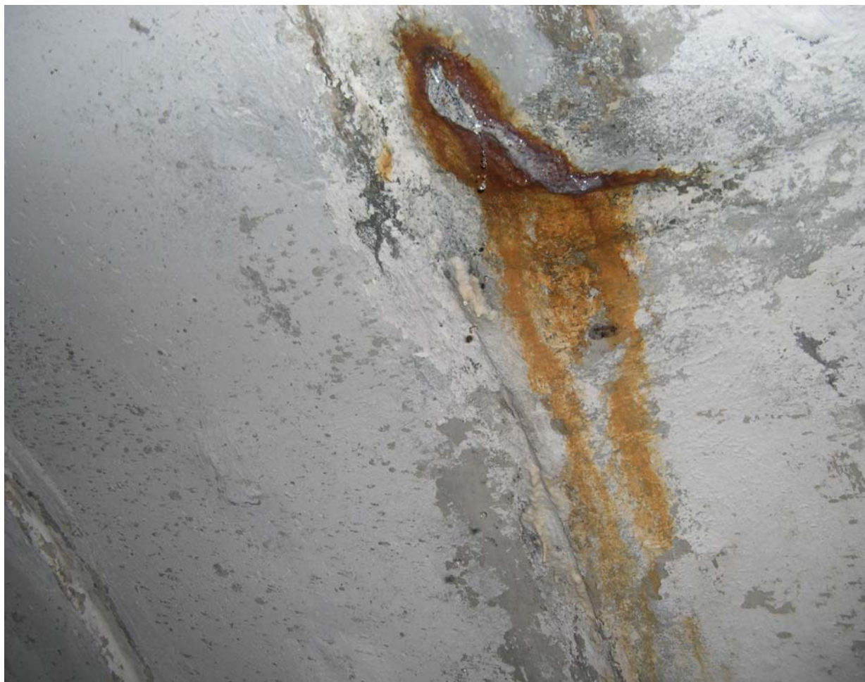
Рисунок 3. Свободное проникновение воды сквозь обделку тоннеля
