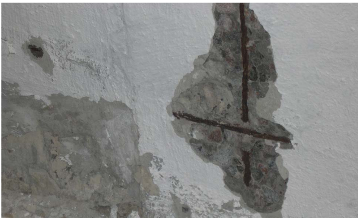
Рисунок 4. Откол защитного слоя бетона обделки в результате коррозии арматуры
